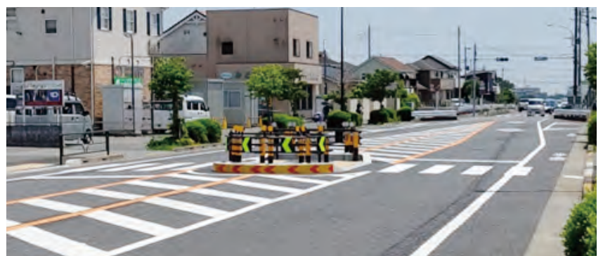
下草花バス停付近に新設された二段階の横断歩道
