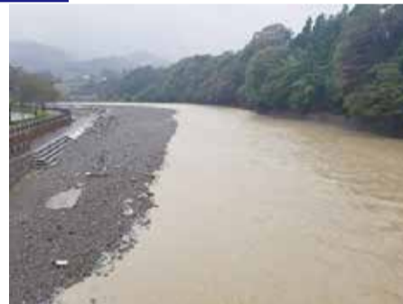
工事前(台風直後)
