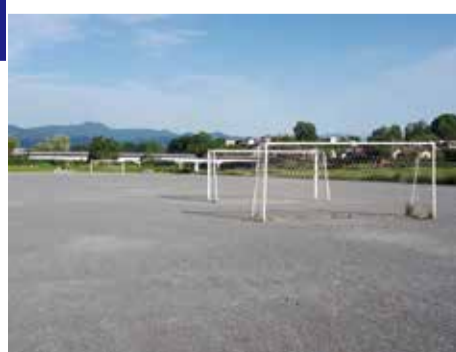
復旧したサッカー場
