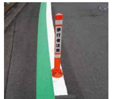
安全ポールの設置
